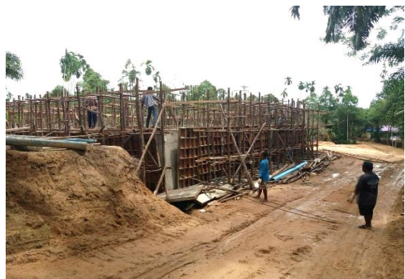
งานก่อสร้างถังพักน้ำ ขนาดความกว้าง 15.00 เมตร ความยาว 20.00 เมตร ความสูง 5.00 เมตร ความจุ 1,200 ลูกบาศก์เมตร
