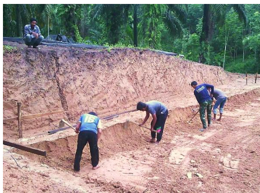
งานก่อสร้างถังพักน้ำ ขนาดความกว้าง 15.00 เมตร ความยาว 20.00 เมตร ความสูง 5.00 เมตร ความจุ 1,200 ลูกบาศก์เมตร
